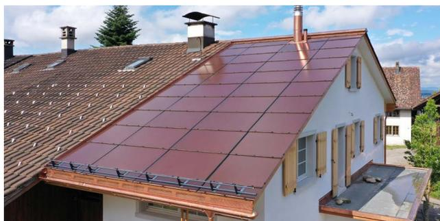
Die optimierte Bilddatei wird im keramischen Digitaldruckverfahren auf das hochwertige Solarglas aufgedruckt und eingebrannt und als Frontscheibe in den mehrschichtigen Aufbau des PV-Moduls integriert. Dabei lassen sich auch individuell gestaltete Motive aufbringen.
